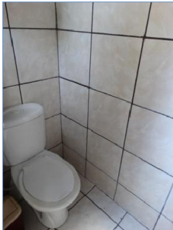
Foto: Casa 3 – Banheiro de serviço
