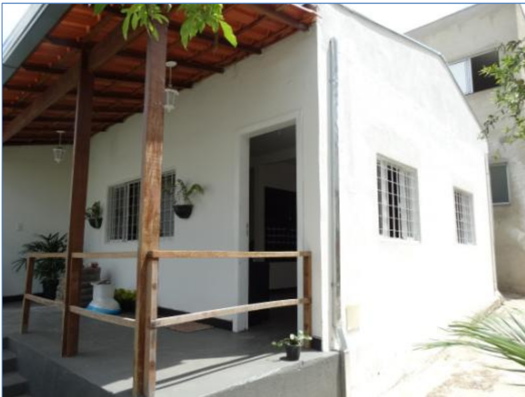
Foto: Casa 1 - Fachada
