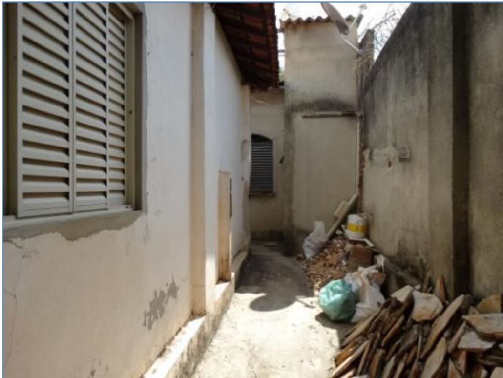
Foto: Casa 3 – Acesso ao fundo da casa 3
