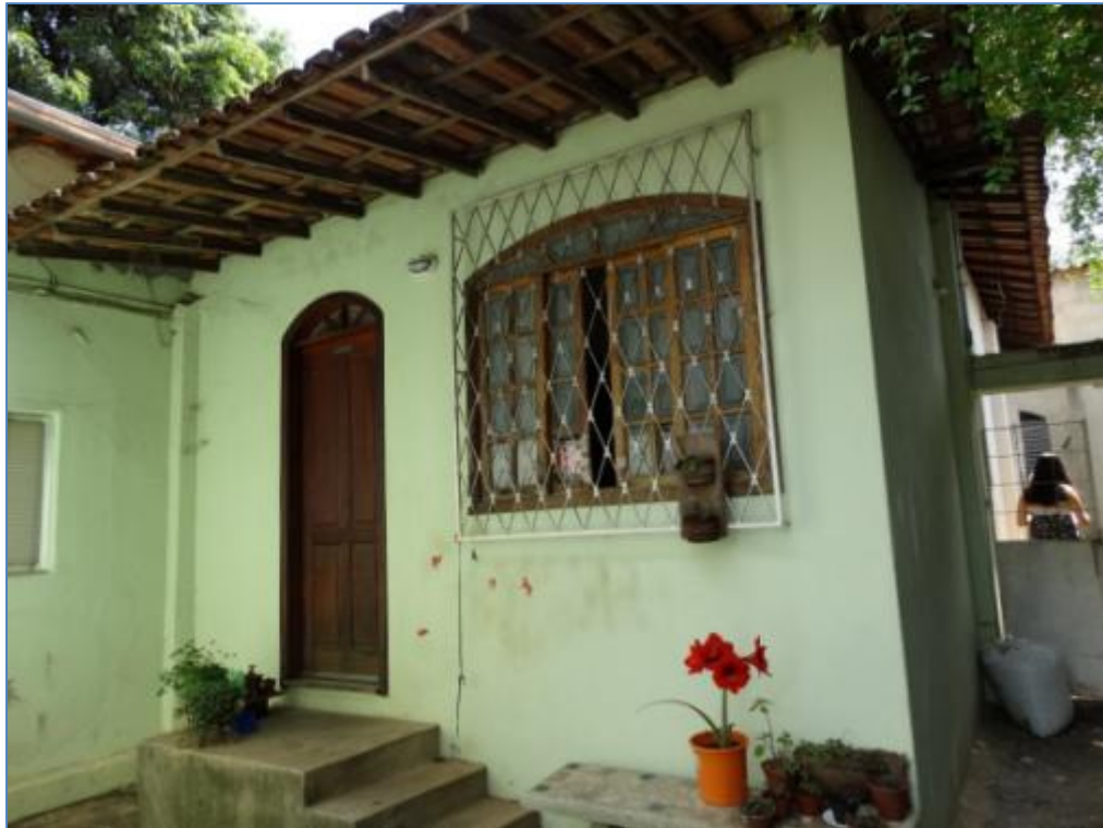
Foto: Casa 3 – Fachada
