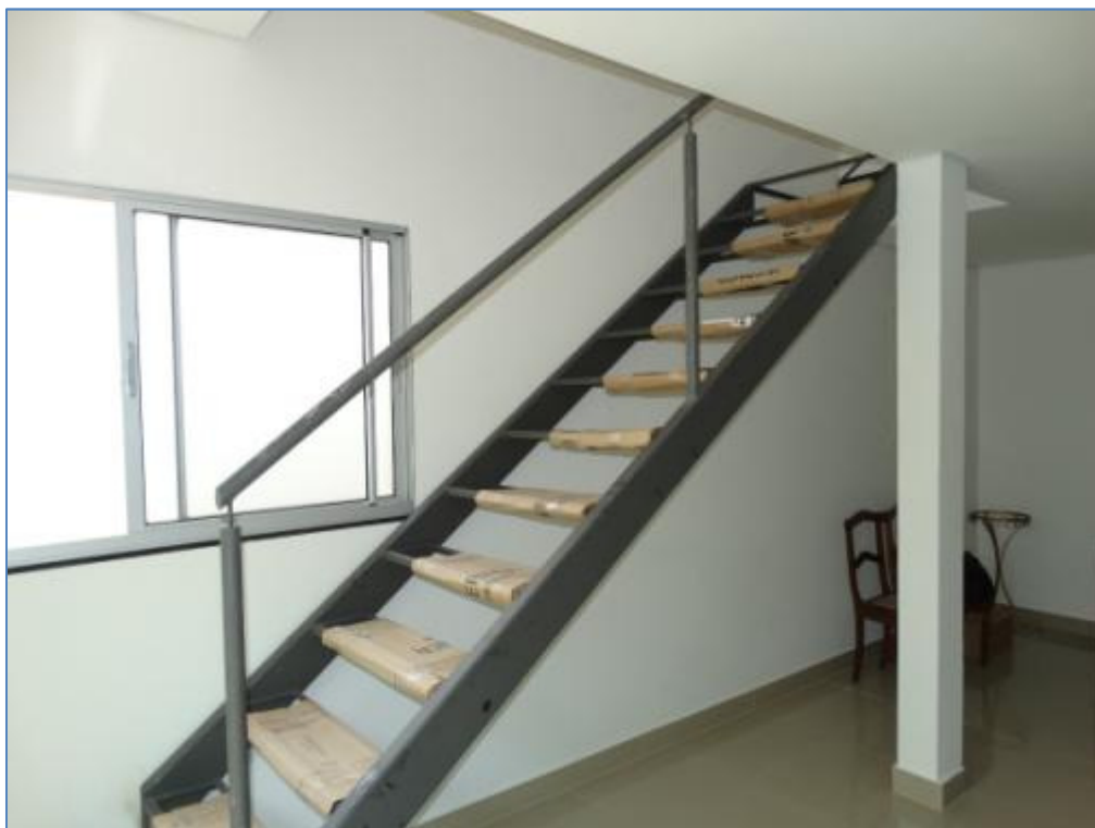
Foto: Casa 2 – 1º pavimento – Escada de acesso ao 2º pavimento
