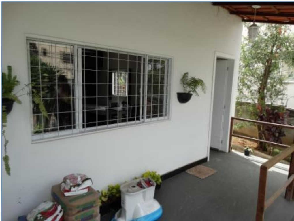
Foto: Casa 1 - Fachada
